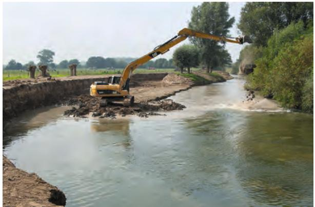
Abb. 62: Zur Anhebung der Sohle füllt der Bagger in der Hellinghauser Mersch bei Lippstadt Sand in die Lippe; nach links wird der Fluss verbreitert.
