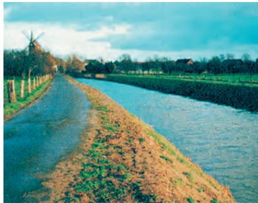
Abb. 25 und 26: Issel vor dem Ausbau bei Loikum 1950 und ausgebaut bei Werth 1999 (aus THIEL & BROGGIATO 2000): Der ausgebaut Fluss ist durch deichartige Verwallungen von seiner Aue getrennt.
