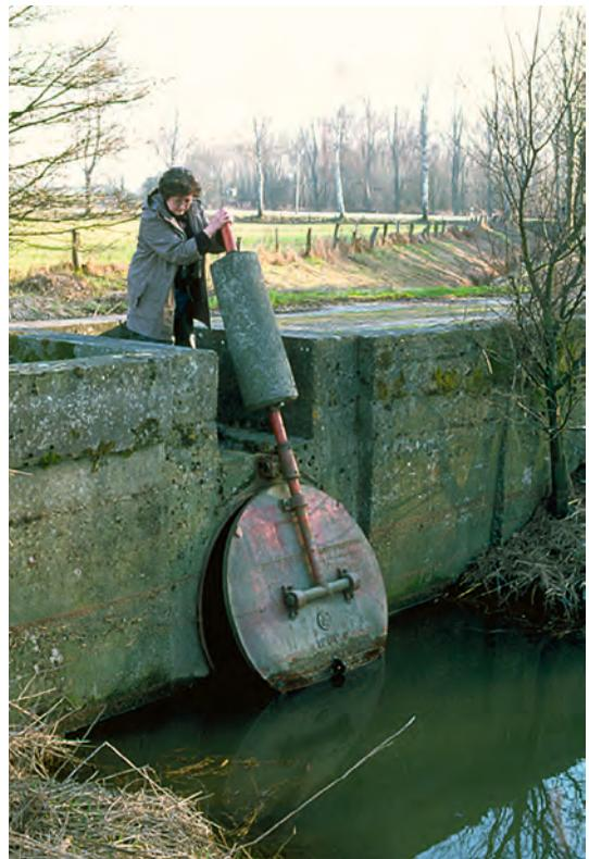
Abb. 27: Bei niedrigem Wasserstand des Flusses drückt der einmündende Bach die Rückstauklappe auf und entwässert die Aue. Steigt der Wasserspiegel des Flusses, wird die Klappe dadurch geschlossen und verhindert die Flutung der Aue, gleichzeitig aber auch den Fischaufstieg.
