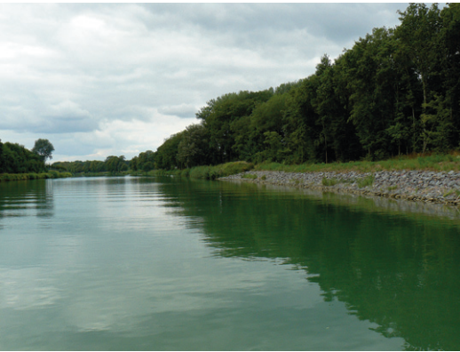
Abb. 2: Ausgebaute Kanalstrecke des Dortmund-Ems-Kanals mit Blocksteinen
