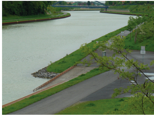
Abb. 3: Ausgebaute Kanalstrecke des Dortmund-Ems-Kanals mit Spundwänden
