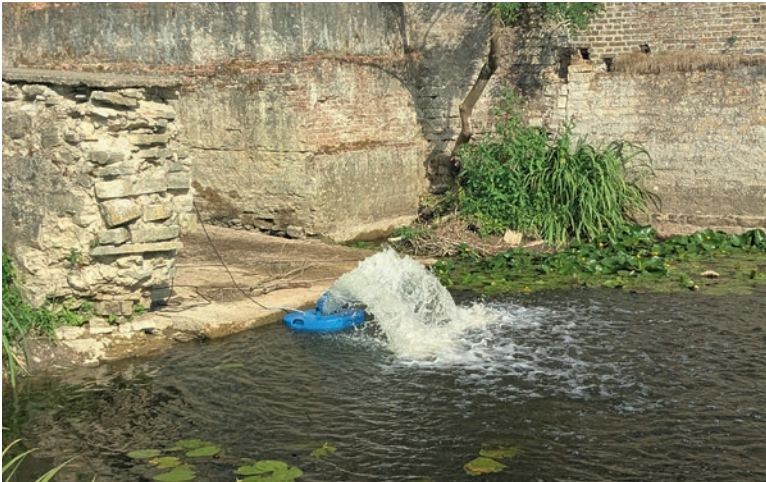
Wasserbelüftungstechnik im Einsatz
