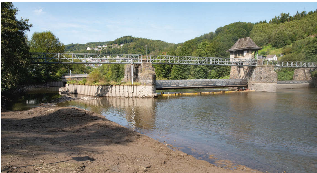
Durch Baumaßnahmen verursachter, plötzlich auftretender niedriger Wasserstand wird für die Fische zur tödlichen Falle. Dies führte an der Lenne bei Werdohl zu einem großen Fischsterben.
