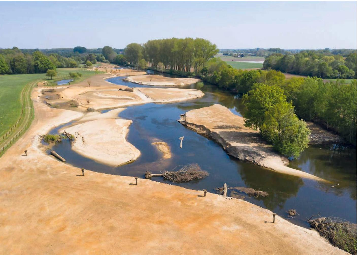
*Bei der Renaturierung der „Ems unterhalb Axtbachmündung“ wurden auf einer Fläche von ca. 6 ha drei neue Emschleifen angelegt und durch Randsenken und Flutmulden ergänzt. Darüber hinaus wurde ein Altarm an die Ems angebunden und eine Verbindung zwischen dem Altarm und dem Nördlichen Talgraben geschaffen.*
