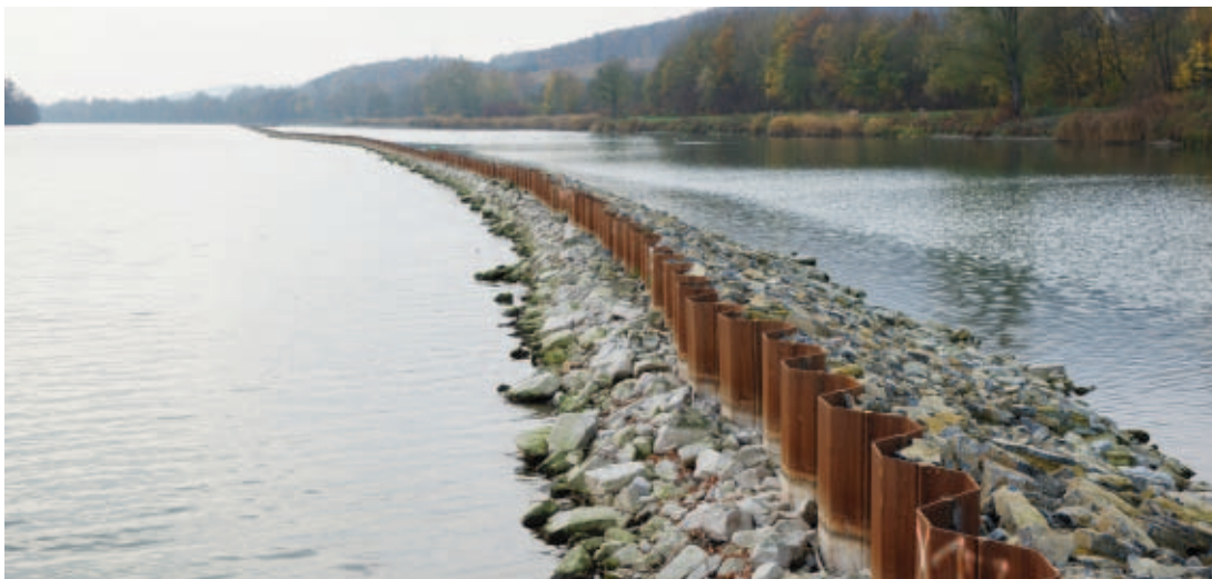
Die Baumaßnahme am Schieder See
