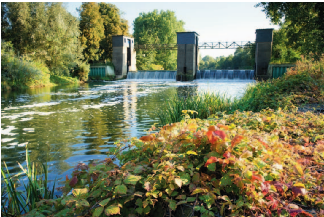
Wehr bei Lünen-Beckinghausen
