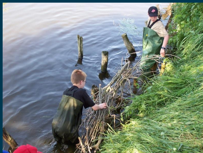
Einbau einer Faschine an einer Abbruchkante
