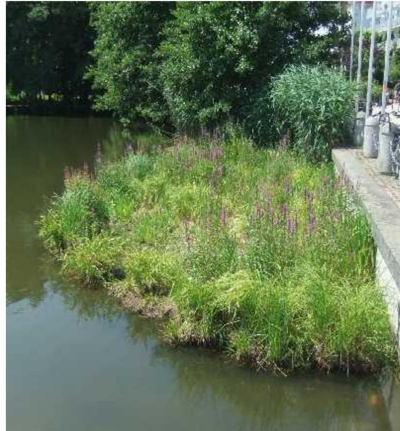
**Wasserseitige Begrenzung der Flachwasserzone mit pyramidenförmig aufgebauten Xylitwalzen.**
