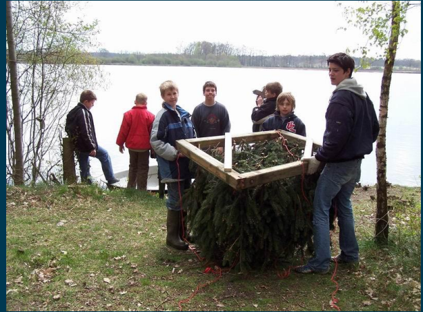
Wenn in einem Gewässer Strukturelemente zum Abblachen fehlen, können auch naturnahe Strukturen wie z.B. eine Laichhilfe aus Tannengrün oder ähnlichem Material eingebaut werden.
