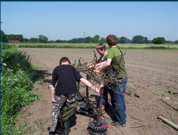
Reisigmaterial wird auf Böcken zusammengelegt und daraus wird eine Faschine gebaut. Die Faschine dient nach dem Einbau in den Uferbereich zur dessen Befestigung und ist zugleich Lebensraum.
