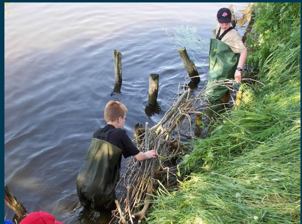
Hier bauen Jugendliche Faschinen in den Uferbereich eines Flusses ein. Neben dem Schutz vor Uferabbrüchen bietet das Totholz zahlreichen Kleinlebewesen Schutz und Entwicklungsmöglichkeiten.
